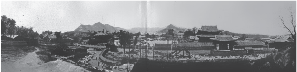
1903년경 경운궁 남쪽 궁궐 담장 공사
